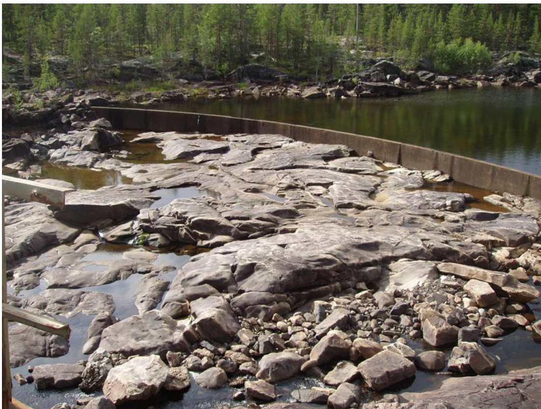
Foto 16. En av två befintliga spegeldammar nedströms Akkats kraftverk. Foto: Patrik Olofsson, Länsstyrelsen 2007.
